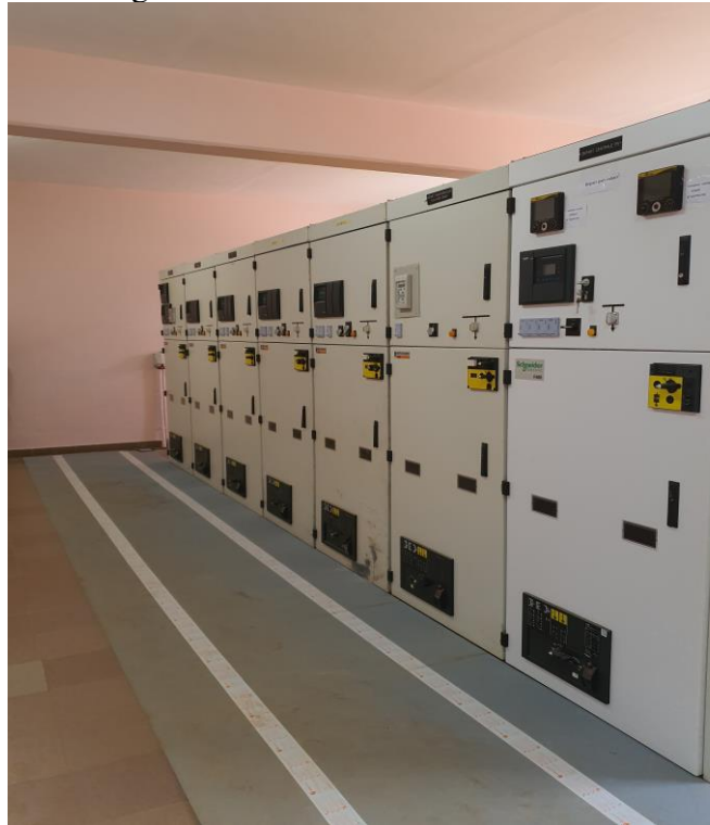
Photo 4 : Tableau HTA existant Type Schneider F400-Dagana
