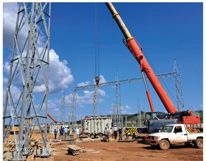
■ Installation des Transfos (2x60 MVA) et réactances (2x20) au Poste de Kambila
