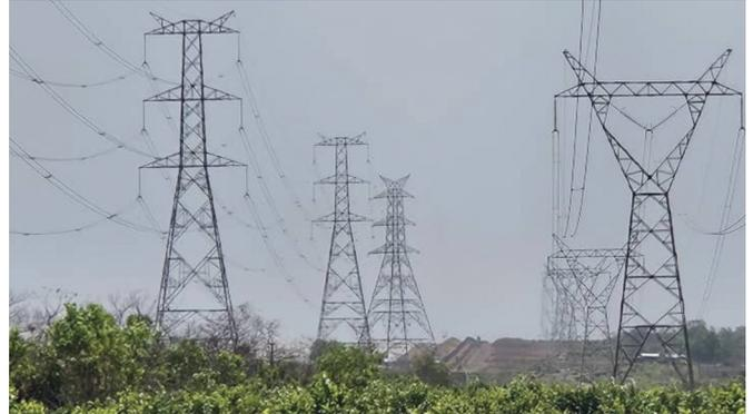
■ A gauche nouvelle ligne 225 kV biterne en cours et à droite ancienne ligne 225 kV monoterne
